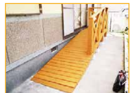
勝手口スロープ
