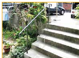
アプローチ手すり
